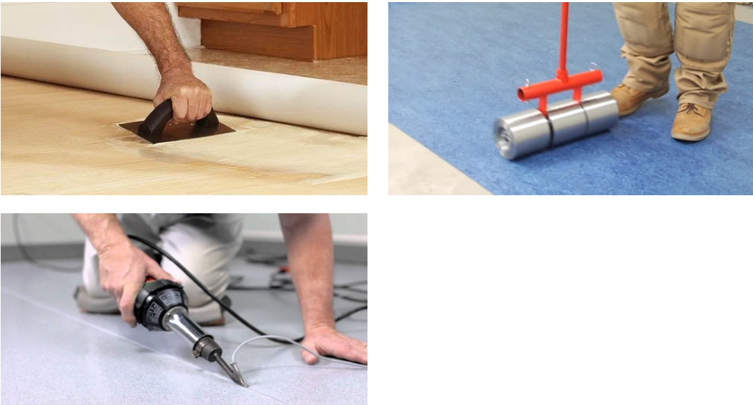
Рисунок 4.1. Приклеивание, укатка и сваривание швов ПВХ линолеума
