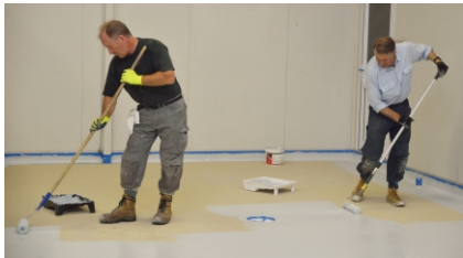
С) Нанесение велюровым валиком
