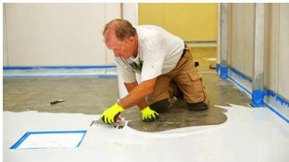
А) Нанесение покрытия шпателем
